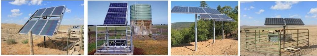
Güneş paneli ile , kuyu - depo , sulama kontrol sistemlerinde elektrik enerjisi olmayan yerlerde elektrik enerjisi üretimi ve uygulamaları
